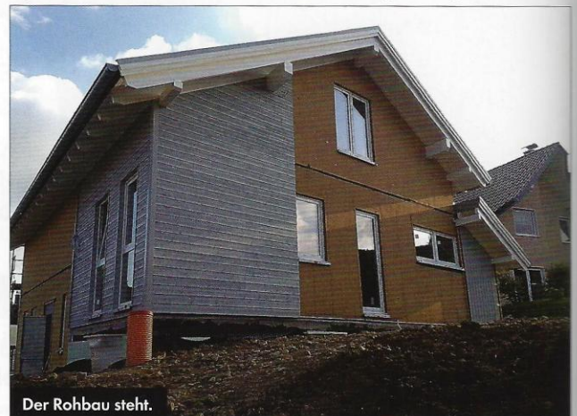
Der Rohbau steht.
